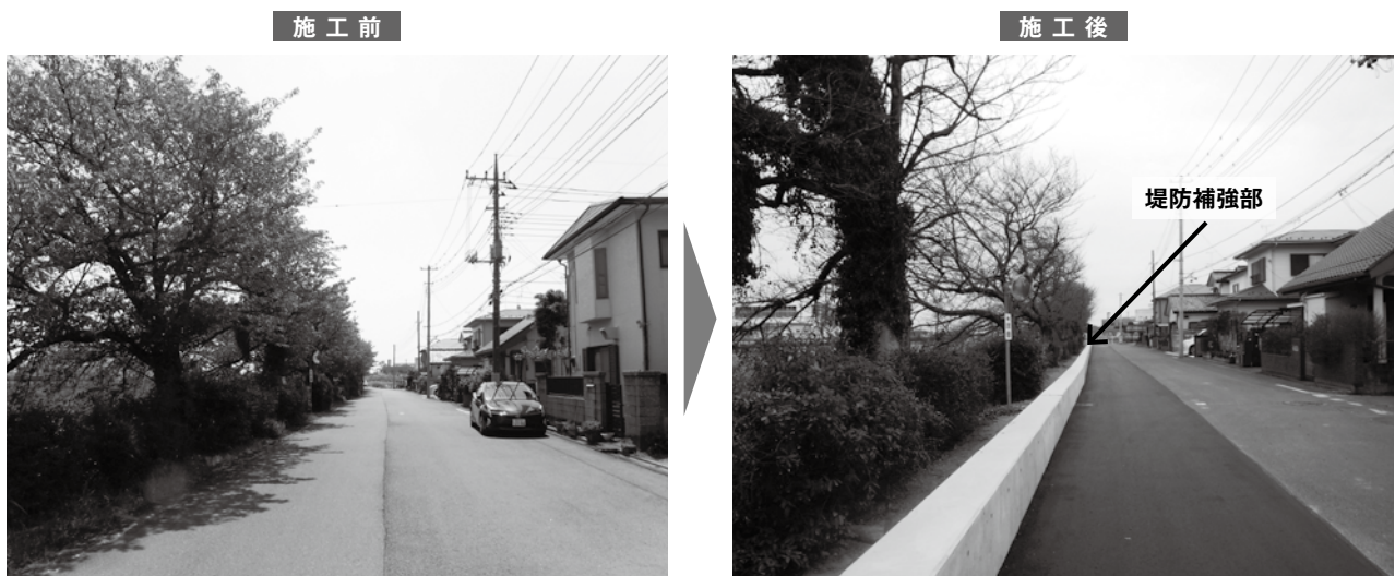
図6 堤防補強状況(施工前後)
