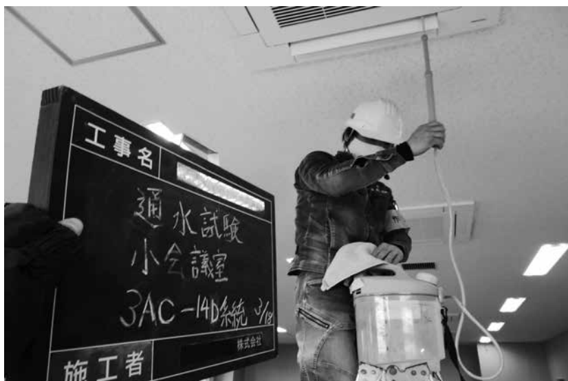
①空調ドレン排水通水試験(例)
