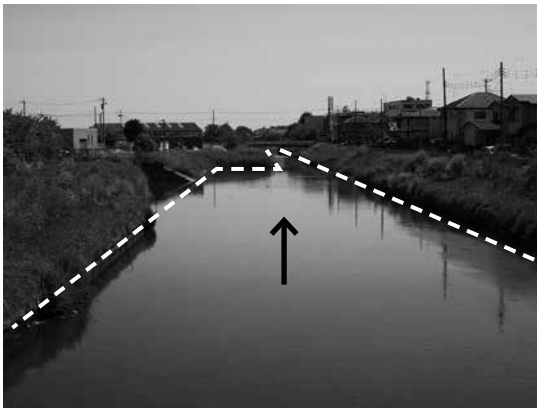
写真4. 現在の河道の状況
