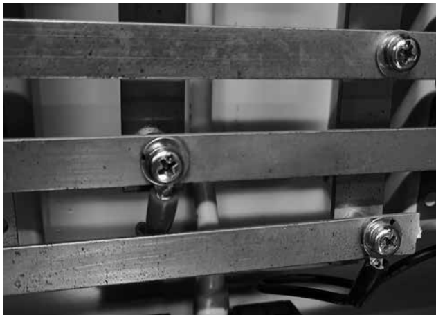
①母線と直角に接続した状況
