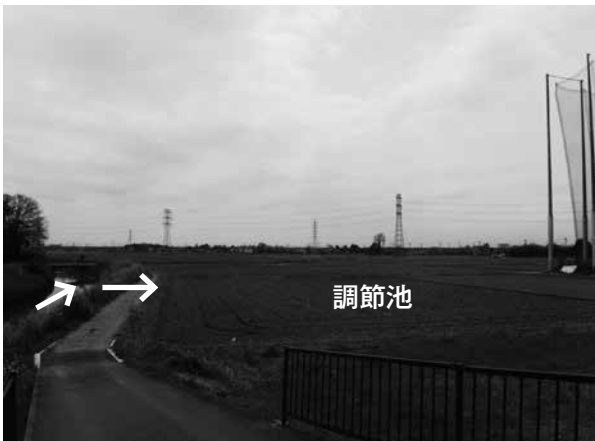
写真5. 下忍調節池整備箇所現地状況
