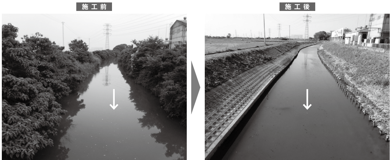
図5 樹木伐採・土砂撤去状況(施工前後)
