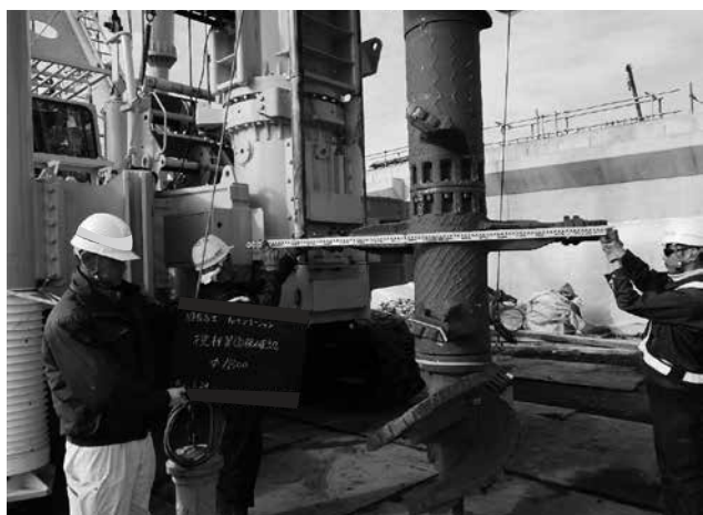
攪拌翼径寸法
