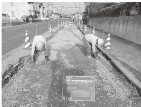
有害物除去の状況
