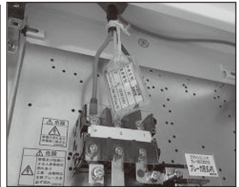
ケーブルへの銘板取付け事例
