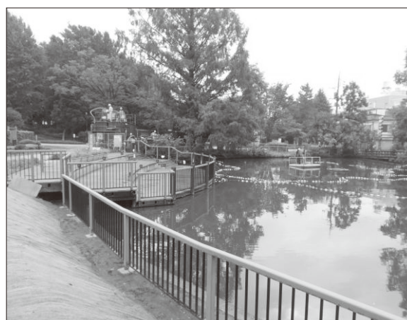
〔転落防止柵、浚渫工〕
