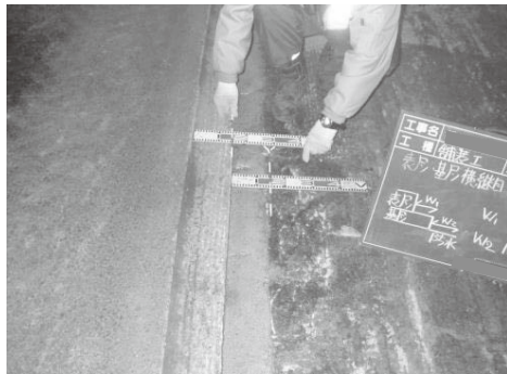
縦継目のずらし写真
