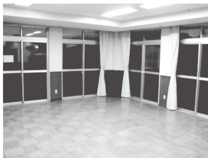
ホール → 内装を改修します
