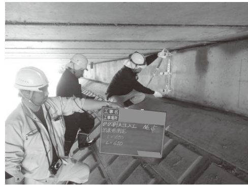
協議に基づく低圧注入工法の出来形確認写真
