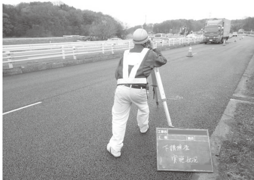
下請完成検査（舗装工）
