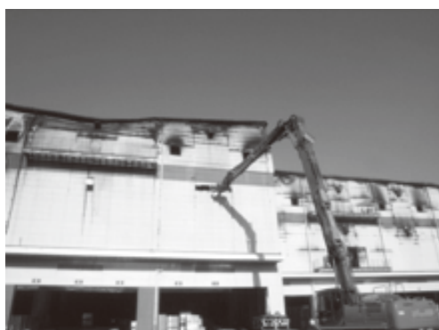
重機による外壁破壊
