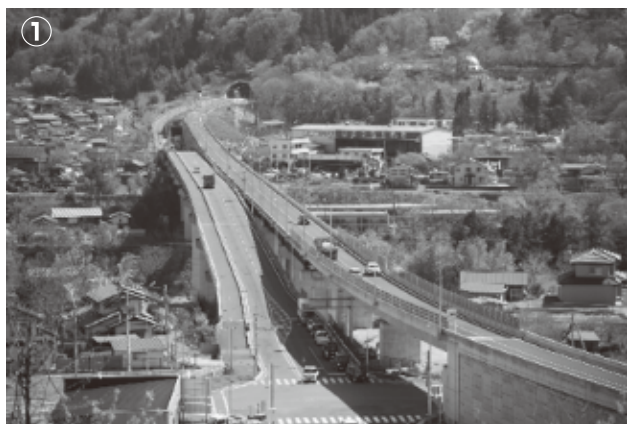
皆野秩父バイパス第一期区間
