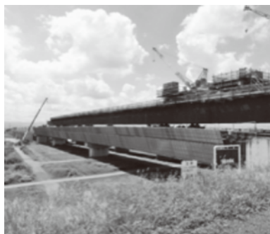
平成28年度 上部工送出し工法
