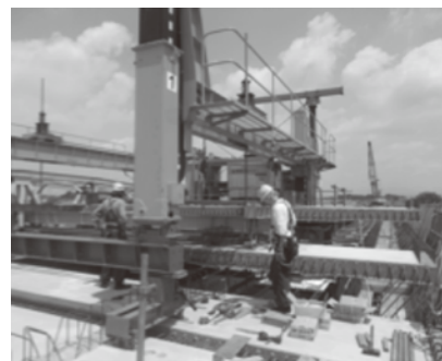
平成29年度 プレキャストPC床版架設
