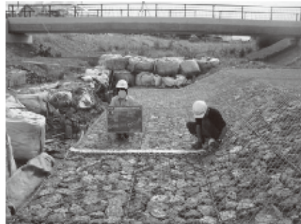
かごマット 法長(底面)の出来形確認写真
