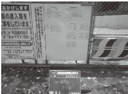
施工体系図掲示状況写真
