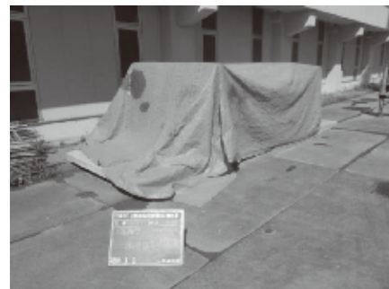
L型擁壁保管状況写真
