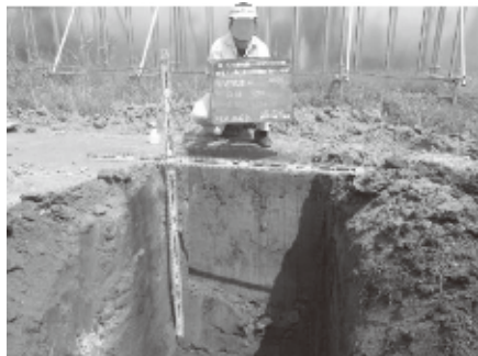
路床改良工 改良厚の出来形確認写真
