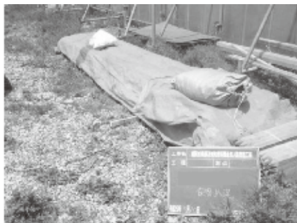
鉄筋保管状況写真
