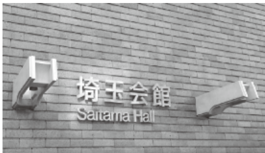
竣工当初を再現した壁面ブラケット照明
