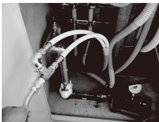
①給水圧力試験の状況
