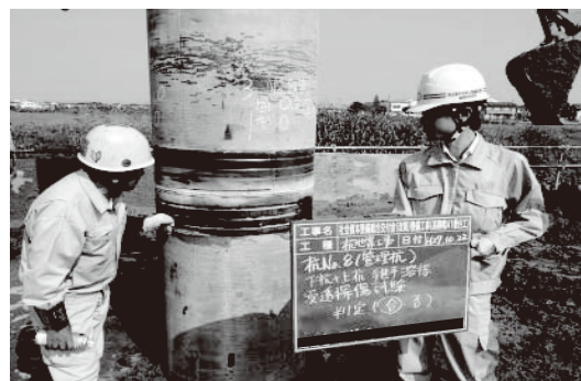
②現場溶接浸透探傷試験
