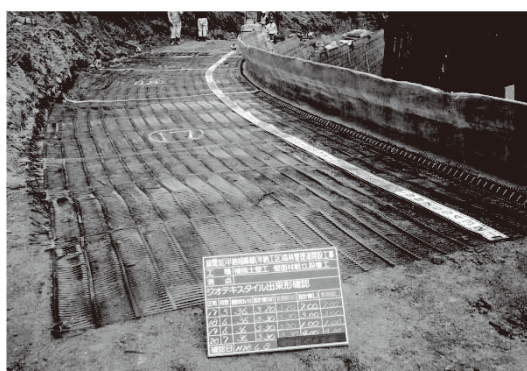
①補強材の敷設
