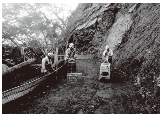
②盛土材の敷均し・転圧
