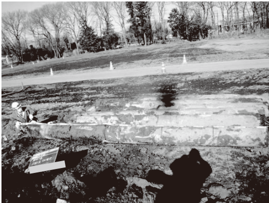
①撤去した杭の長さの写真
