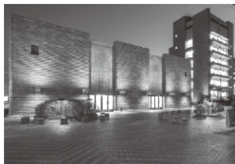
打込タイルと打放しコンクリートの対比が美しい外観
