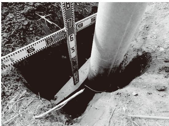
①根かせの設置状況
