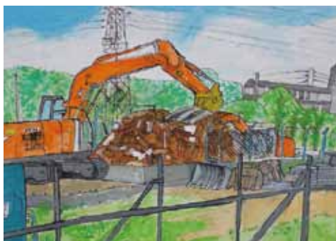
嵐山町立菅谷小学校 6年 安藤 柁平 さん 『プールの解体工事』
