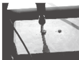
【⑥ アンカーボルト打込】
