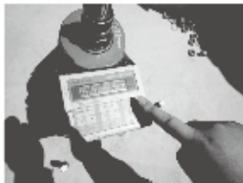
【⑦ 引き抜き試験】
