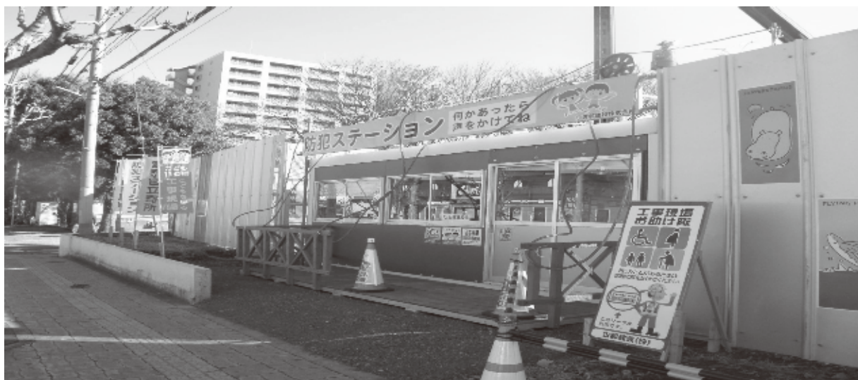
【東入間警察署建設工事着工中、古郡建設様に設置していただいた防犯ステーション】
