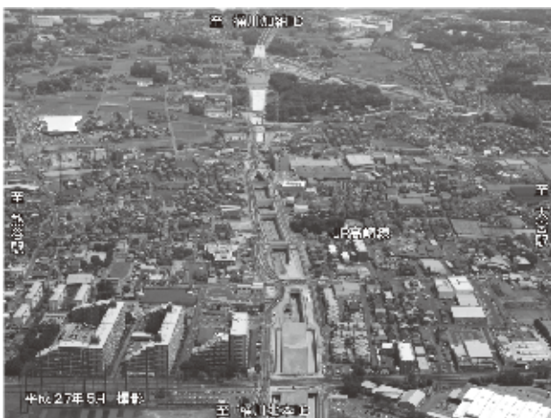
① J R 高崎線交差部付近
