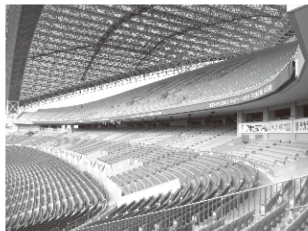
帯状映像装置の新設
