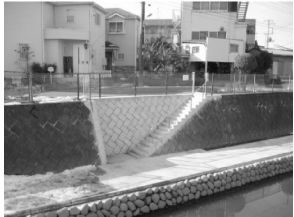
階段通路整備
