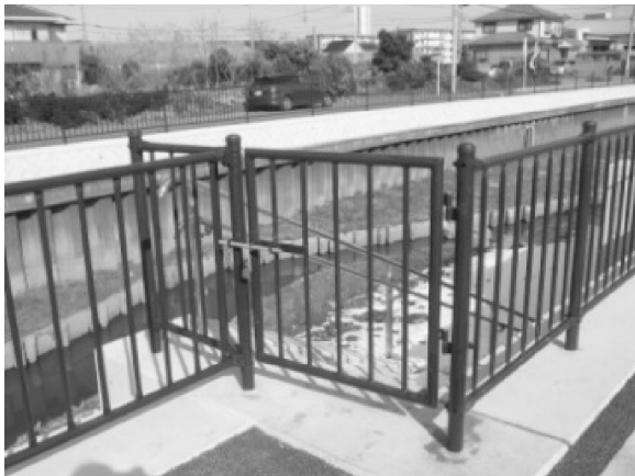
扉付きフェンス設置
