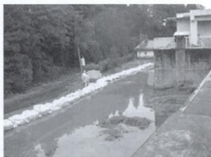
汚水の流出(処理場) (平成16年 新潟県中越地震)
