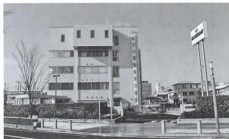
埼玉電気会館
