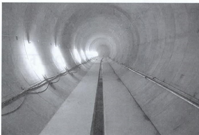
(図3 地下河川坑内)
