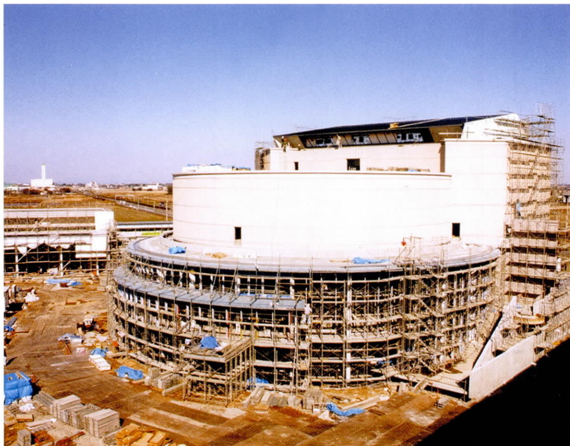
建設の進む市民文化会館「キラリ☆ふじみ」
