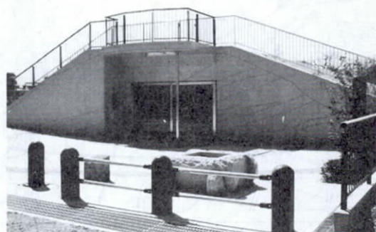
▼断面見学施設
