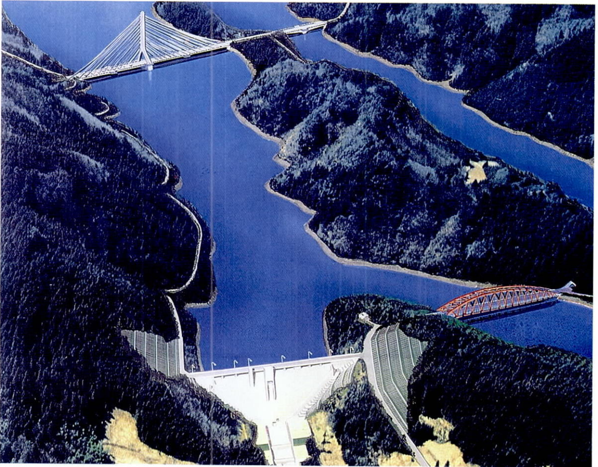
竣工間近い県営合角ダムの全容 (図)
