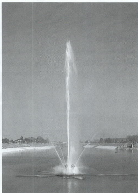
完成した大噴水の景観 (県ダム砂防課提供)
