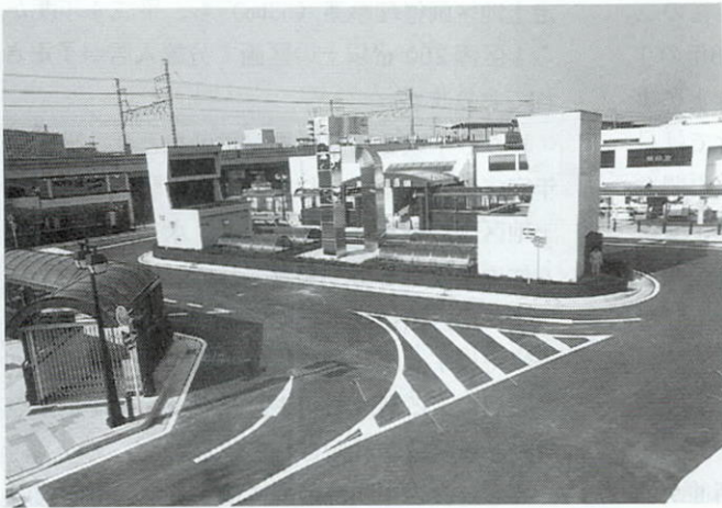
朝霞台駅南口地下自転車駐車場
